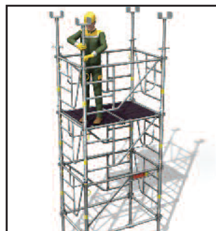
> 11- Mise en place et réglage des vérins de tête.
