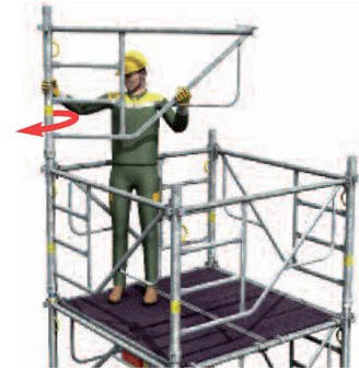
Pose d'un plancher :
