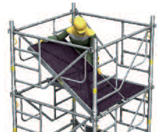
Pose d'un plancher :
