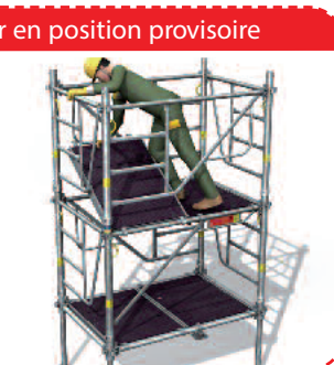
> 6- Accès au niveau supérieur puis pose du 2 e plancher à trappe 1 m.
