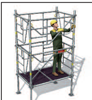
> 4- Pose de 2 planchers à trappe de 1 m et montage du 2 e niveau.
