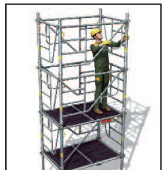
> 7- Montage du 3 e niveau.
