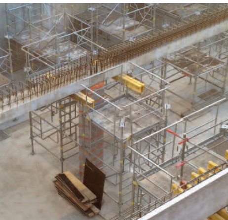
> Passage sous les poutres : 4 garde-corps de clavetage en position basse.
