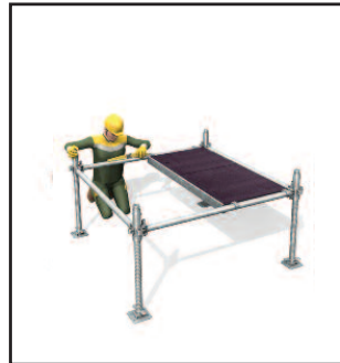
> 1- Implantation et mise à niveau. Vérification de l'équer-rage en poussant un plancher dans l'angle.
