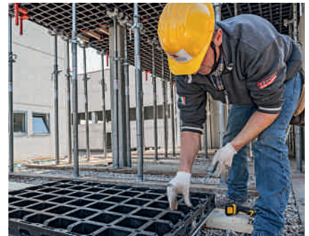
4. Vissage de la nouvelle peau coffrante
