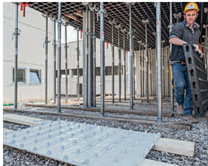
3. Mise en place de la nouvelle peau coffrante
