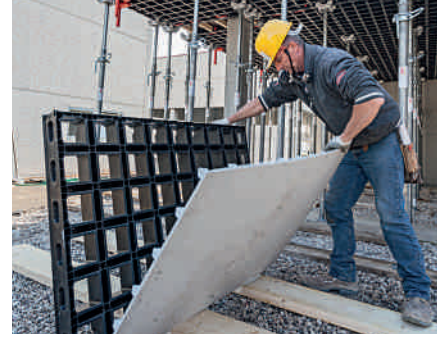
2. Enlèvement de la peau coffrante endommagée
