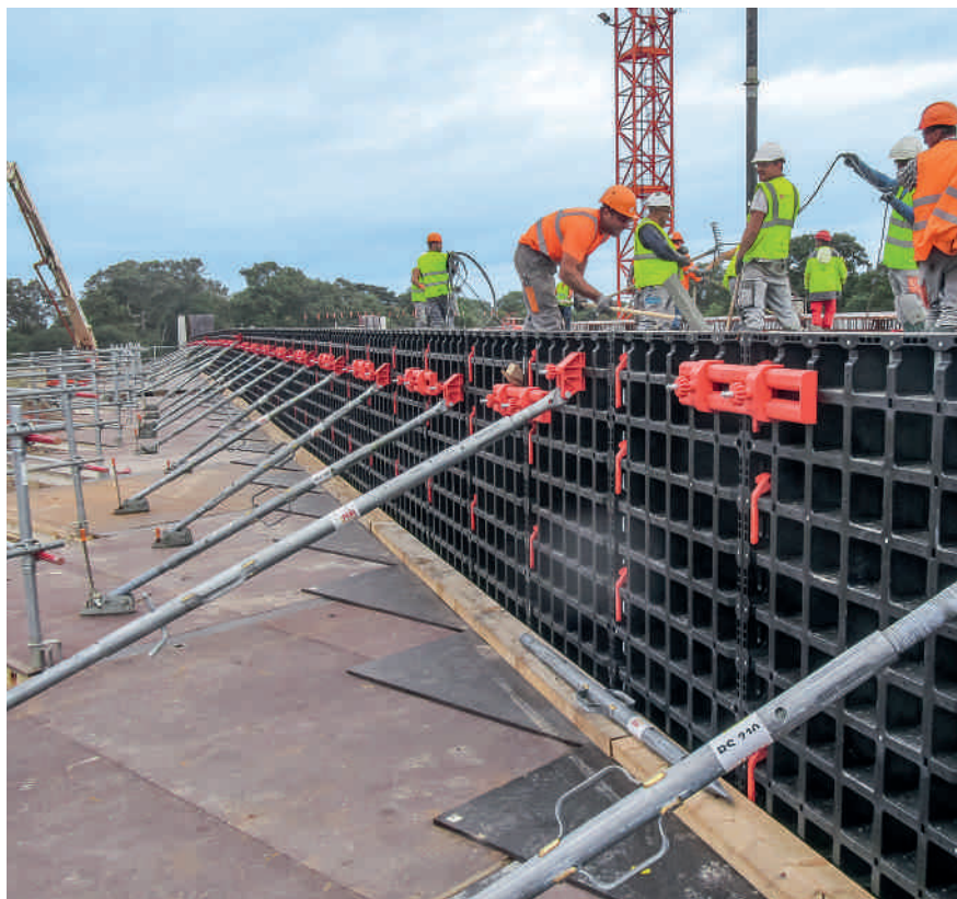
Panneaux de petites dimensions et la simplicité de manipulation prédestinaient DUO au coffrage de fondations.
