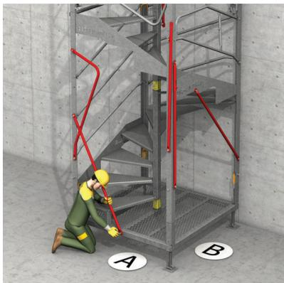
> **9** - Au niveau des entrées, positionnement des lisses en privilégiant l'entrée principale face A (les faces sont repérées sur l'autocollant).
