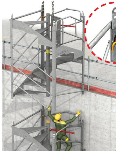
> **7** - Avec les élingues accrochées aux 2 anneaux de levage, pose du module de tête. Assemblage des 4 montants avec vis M24.
