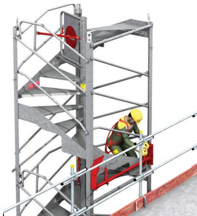
> **1** - Pose des supports passerelle gauche et droit. Suivant la configuration, mise en place de la lisse 1,50 m en haut ou en bas sur les supports et positionnement des colliers de reprise à 0,30 m (ou 0,15 m) du montant du module.
