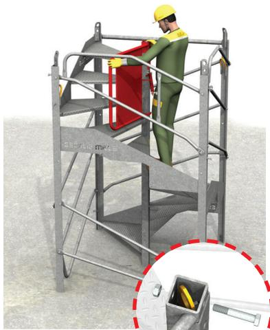
> **6** - Mise en place et boulonnage du garde-corps de fermeture : la lisse de montage est en position horizontale.
