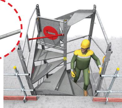
> **8** - S'assurer que les amarrages sont installés avant le décrochage des élingues. Basculement des garde-corps pour permettre la sortie au niveau souhaité.
