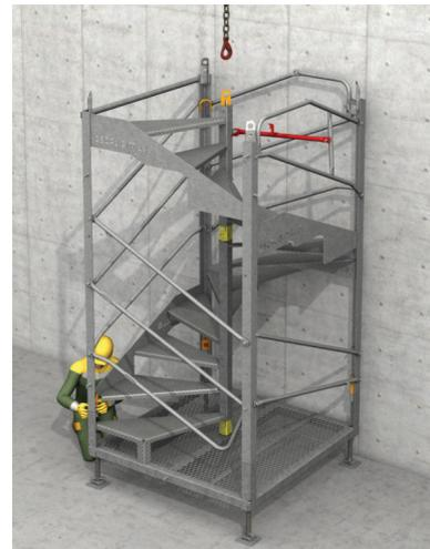
> **3** - Pose du module sur l'embase. Assemblage des 4 montants avec vis M24. Décrochage de l'élingue.
