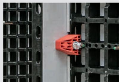
... puis vissé à bloc avec l'ancrage d'angle DUO à travers le trou d'ancrage prévu dans le panneau multifonctions.
