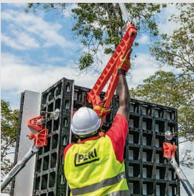
Le montant est d'abord inséré dans la console de bétonnage, puis la console est simplement accrochée dans le panneau. Enfin, des planches de platelage et planches de garde-corps de 5 cm d'épaisseur sont mises en place et fixées à l'aide de vis ou de clous.
