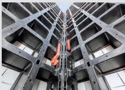
Des angles de 90° peuvent être réalisés en continu. Si des cales de compensation sont nécessaires, celles-ci sont insérées entre le dernier panneau mural et le panneau d'angle.
