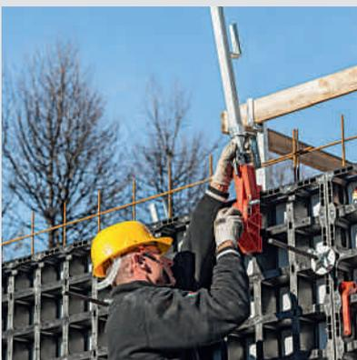
Un garde-corps constitué de trois éléments standards et de planches de garde-corps offre la sécurité requise du côté opposé : la fixation d'étais avec support de garde-corps complété est montée sur le panneau ; il suffit d'insérer ensuite le montant de garde-corps.
