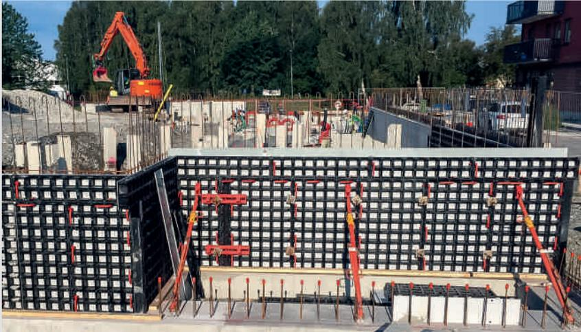
La combinaison de panneaux de 135 cm et de 0,60 m de hauteur permet d'obtenir des hauteurs de voiles de 2,55 m, 2,70 m et 3,30 m. On atteint une souplesse maximale dans l'adaptation en hauteur par l'adjonction de panneaux de compensation de 15 cm pour la superposition.
