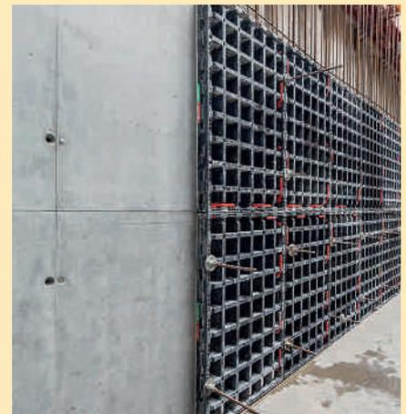
L'adhérence du béton étant quasiment inexistant, les panneaux se décoffrent facilement. Il en résulte d'excellentes surfaces.
