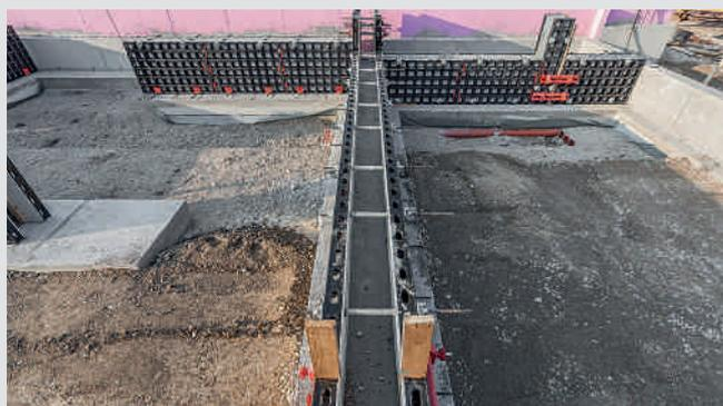
Les écrous-disques standards DW 15 sont utilisés lorsque sont prévus des panneaux multifonctions. Les écrous 3 oreilles sont utilisés pour des fondations avec panneaux standards, l'écrou-disque ne pouvant être placé directement au-dessus du sol.
