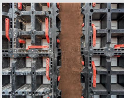
Le support de compensation se fixe sur les côtés du panneau à l'aide de connecteurs et est recouvert d'une cale bois de 18 mm d'épaisseur. Des compensations de 9 cm à 25 cm peuvent être ainsi coffrées.
