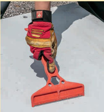
On utilise l'outil universel pour le nettoyage après le décoffrage. Les restes de béton sont éliminés à l'aide de cet outil.
