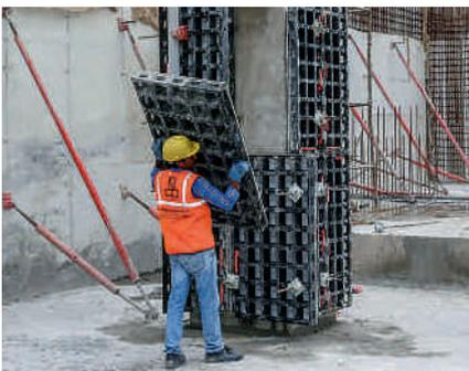
Les panneaux multifonctions DUO permettent de réaliser des poteaux carrés et rectangulaires de 15 cm x 15 cm à 55 cm x 55 cm en trame de 5 cm.
