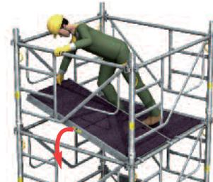
Descendre le plancher en prenant appui sur le cadre.
