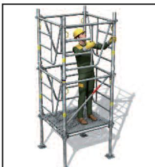
> 2 - Mise en place de 3 planchers de 0,30 m puis pose des cadres du 2<sup>e</sup> niveau.
