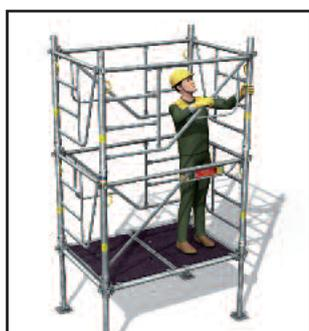
> 4 - Pose de 2 planchers à trappe de 1 m et montage du 2<sup>e</sup> niveau.
