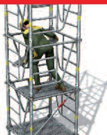
> 5 - Enlever 2 planchers de 0,30 m et descendre au niveau inférieur puis enlever le 3<sup>e</sup> plancher.
