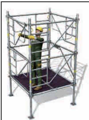
> 4 - Pose de 2 planchers à trappe et montage du 2<sup>e</sup> niveau.
