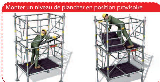
**Monter un niveau de plancher en position provisoire**
