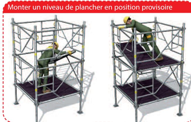
> 5 - Pose d'un 1<sup>er</sup> plancher à trappe.
