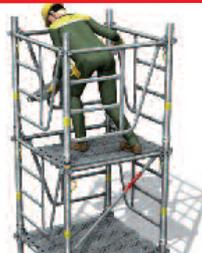
> 3 - Mise en place d'un plancher de 0,30 m puis accès au niveau supérieur par l'échelle intégrée. Compléter par 2 planchers de 0,30 m.
