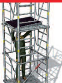
> 6 - Mise en place d'un panacier de 0,20 m et d'un plancher à trappe.
