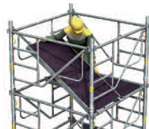
Pour faciliter la pose, maintenir l'extrémité avec la main droite et l'avant-bras. Poser en premier les 2 crochets sous l'échelle.
